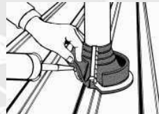
4. Dichtungsmasse auftragen und Dektite Retrofit formgenau an Profilblech anpassen
