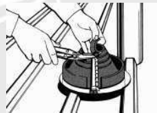
1. Dektite Retrofit an Rohr anpassen
